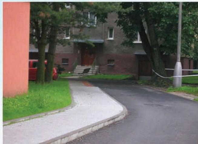
Inovace projektu spočívala v realizaci přirozené vodící linie (osazením obrubníků 60 mm nad nově položenou zámkovou dlažbu) pro osoby tělesně postižené. Rovněž v místě nástupů (nájezdů) na chodník je silniční obrubník snížen na 20 mm nad komunikaci a chodník je opatřen signálními pásy ze zámkové dlažby pro osoby tělesně postižené.
